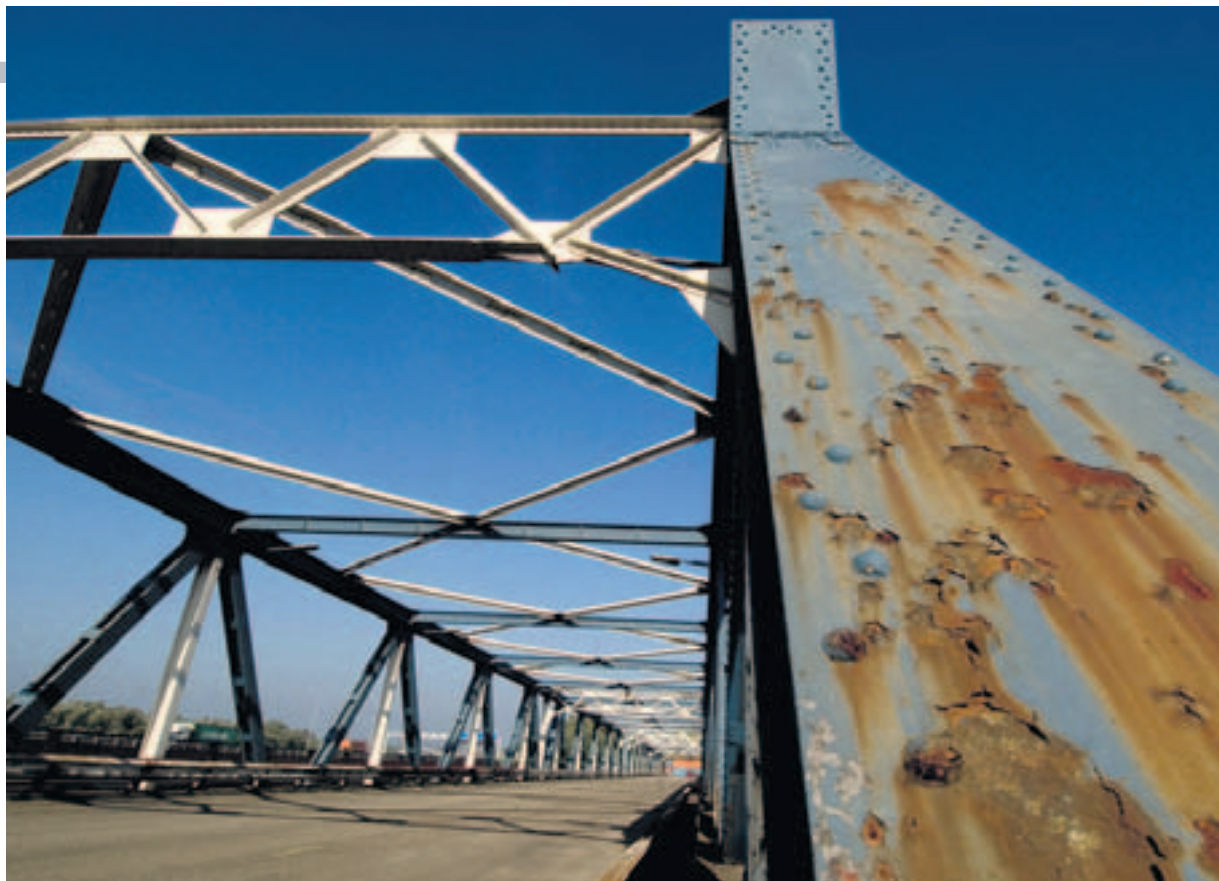
De brug bij Zaltbommel die Martinus Nijhoff zag, wordt al jaren niet meer gebruikt. | foto ANP/Ruben Schipper
